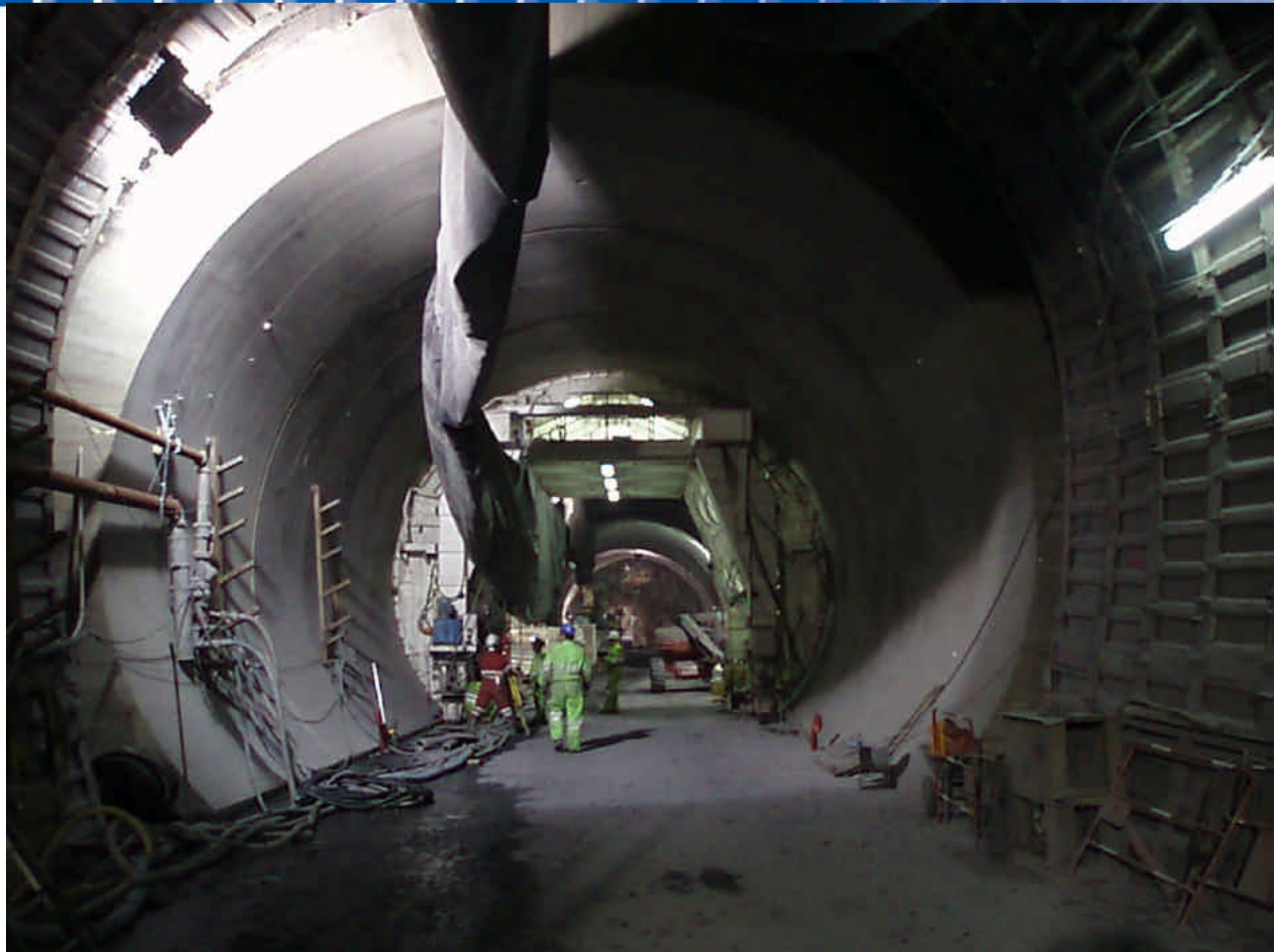
Anneau béton de soutènement définitif
